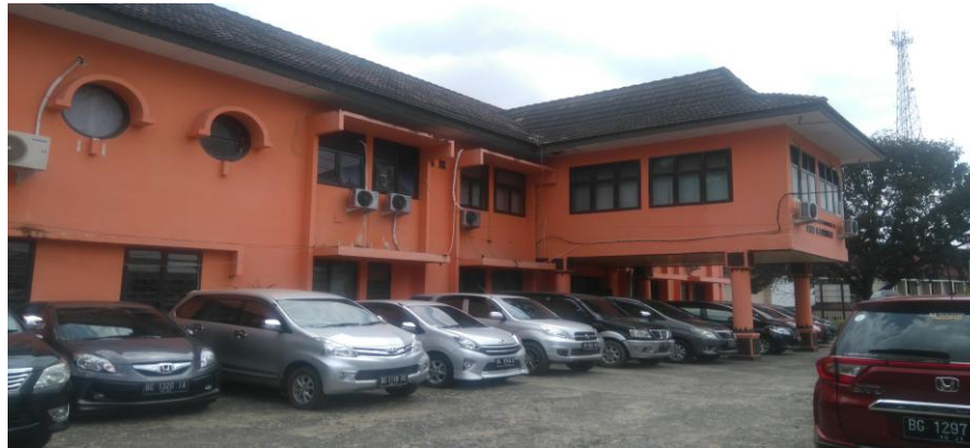
Gambar 9. Tampak samping Gedung Kantor Bersama Dinas Kependudukan dan Pencatatan Sipil Provinsi Sumatera Selatan
